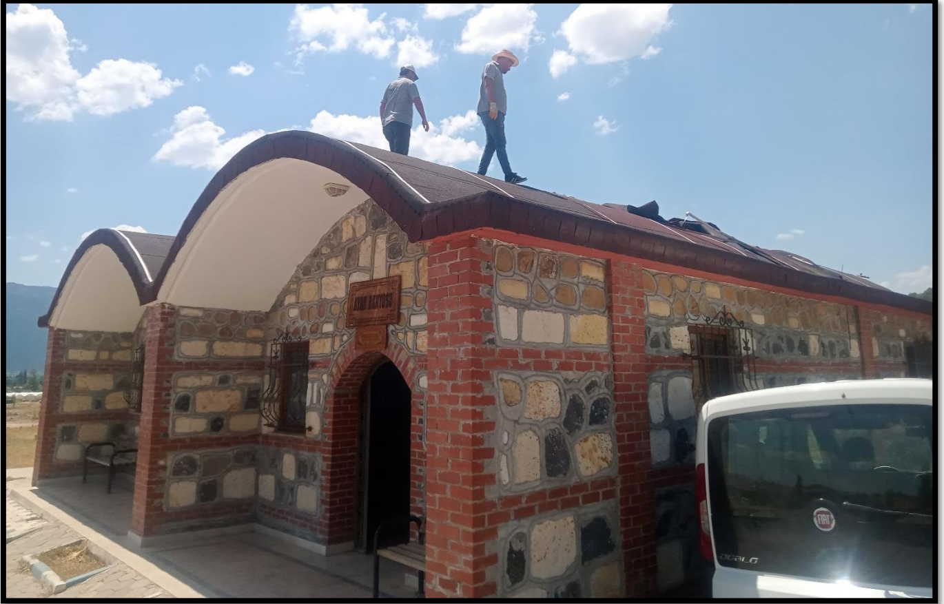
Eynal Kaplıcaları Ayak Banyosu Çatı Tamirâtı Yapım Çalışmaları
