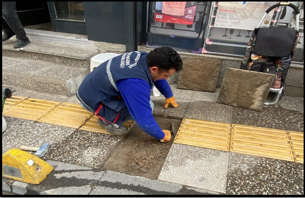
İlçemiz içerisindeki kaldırımlarda bozulan karoların onarım çalışmaları
