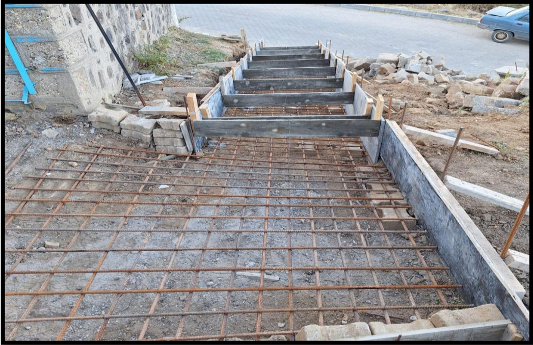
İlçemiz Hisarardı Mahallesi Akbaldır Mezarlığına Merdiven Yapım Çalışmaları
