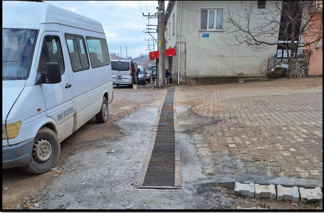
İlçemiz Beyce Mahallesinde Yağmursuyu Izgarası Yapım Çalışması
