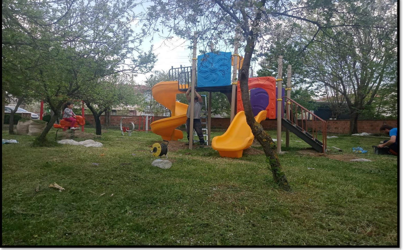
İlçemiz Yeşilova Mahallesinde Yeni Çocuk Oyun Parkı Yapım Çalışmaları
