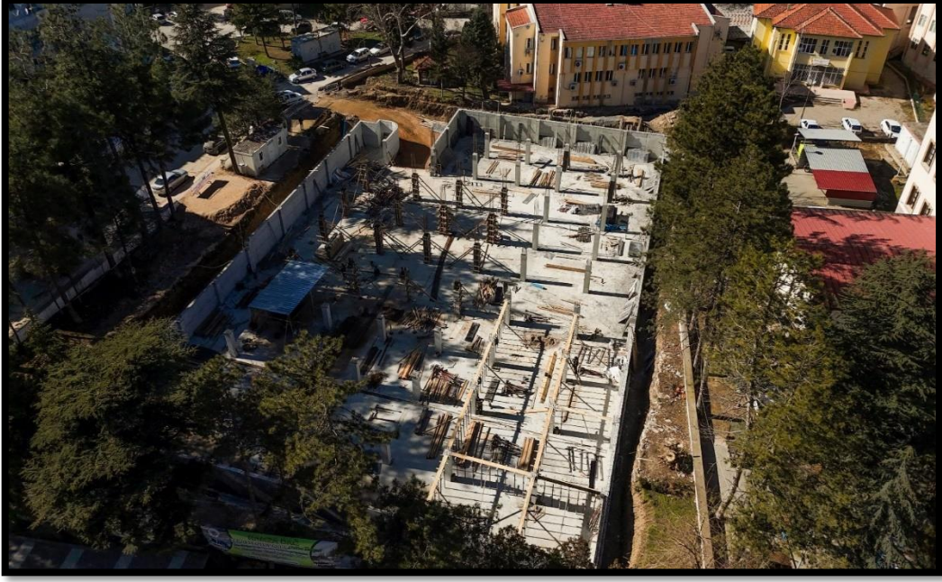
İlçemiz Eski Askerlik Şubesi Arsasına Millet Bahçesi ve Kapalı Otopark Yapımı Çalışmaları Belediyemiz Personelleri Tarafından Yapılmaktadır.
