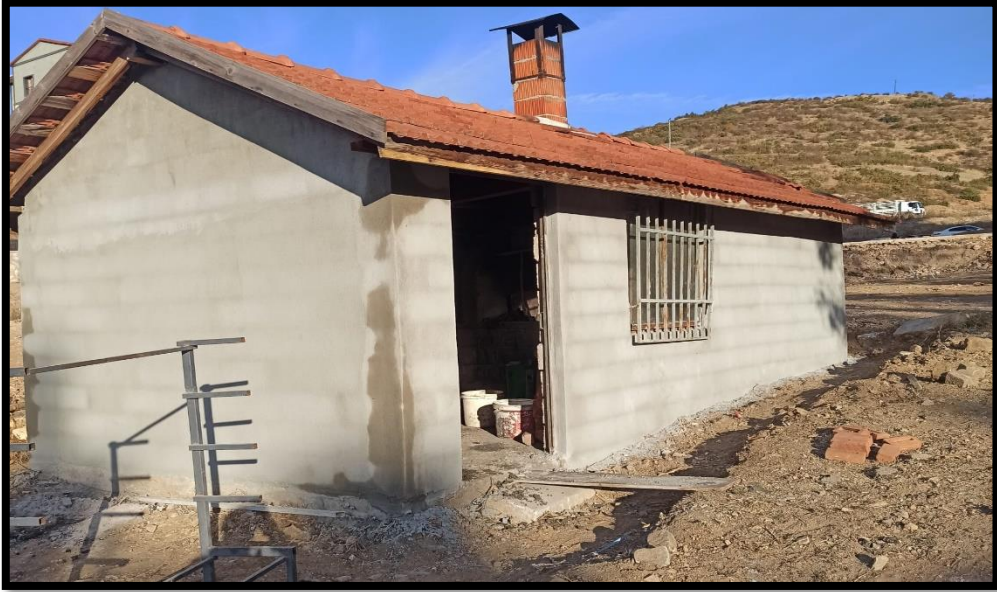
İlçemiz Muradınlar Mahallesi TOKİ Konutları Bölgesine fırın yapım çalışmaları
