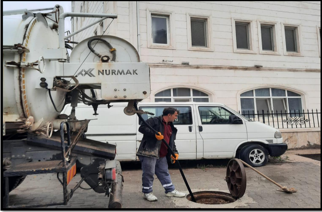
İlçemiz içerisindeki tıkalı olan rögarları açma çalışmaları
