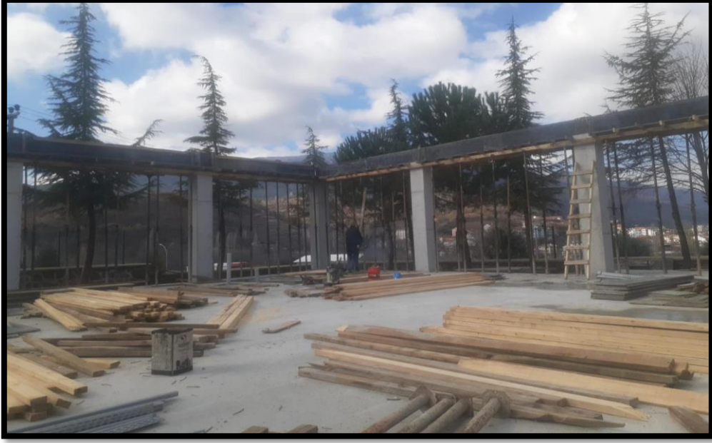
Dumlupınar Üniversitesi Sağlık Bilimleri Fakültesi Bahçesine Kafeterya İnşaatının Yapımı Belediyemiz Ustaları Tarafından Yapılmaktadır.
