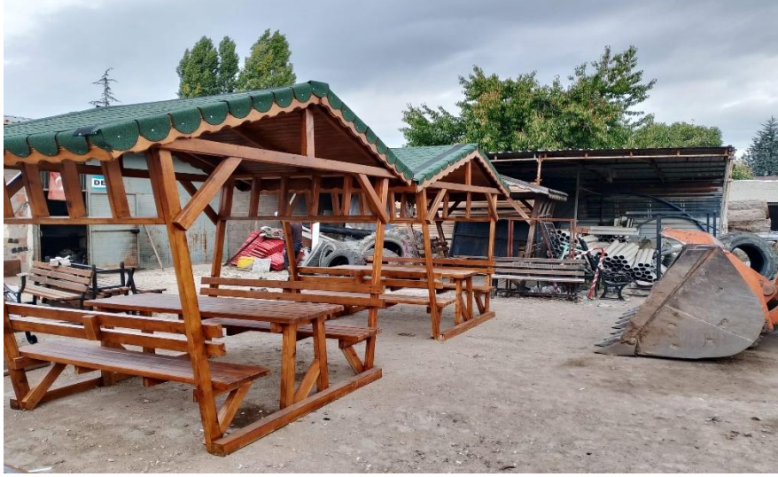
Müdürlüğümüz bünyesinde kamelya yapım çalışmaları
