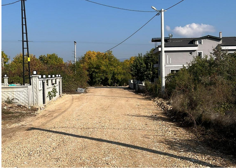
Esenevler Mahallesi Yeni Stabilize yol yapım çalışmaları
