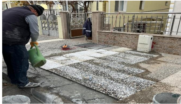
İlçemiz içerisinde kaldırım karo onarım çalışmaları
